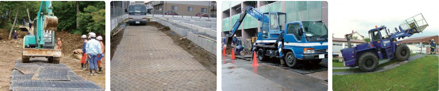
災害復旧現場 住宅現場 マンション外溝工事 重機通路
