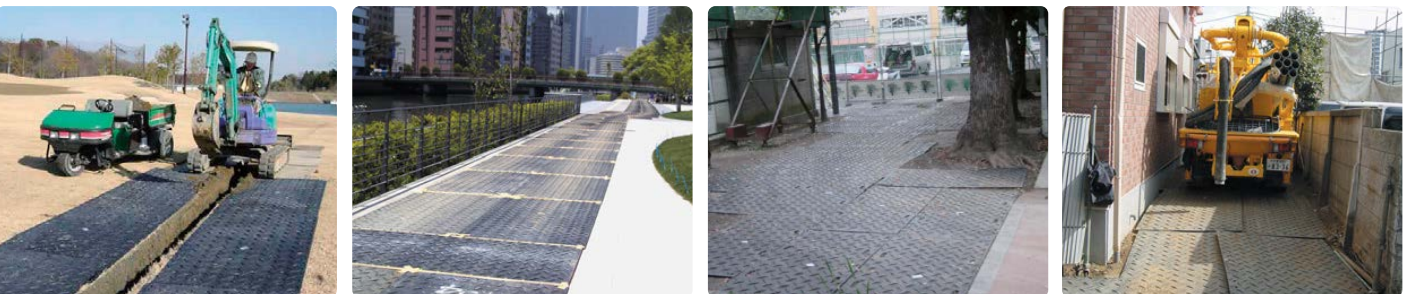
ゴルフ場整備 建築現場車両通路 小学校施設内 狭小地通路
