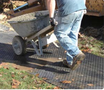
作業通路養生
